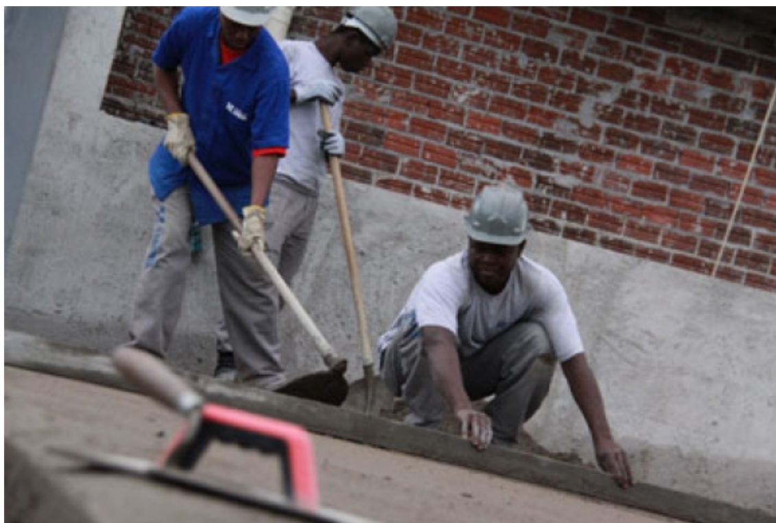
Figura 5 - Haitianos trabalhando no setor da construção civil em Lajeado/RS
