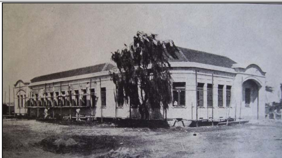
Figura 4 – “Edifício da Escola de Artes e Ofícios em construção” Fonte: Album de 1922
